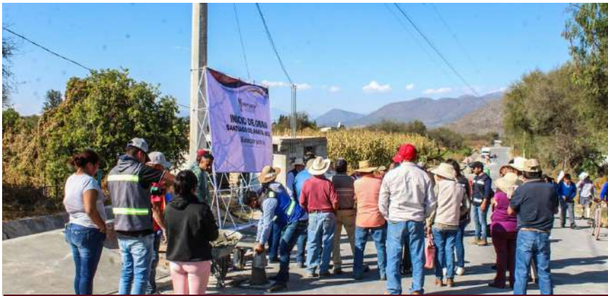
inicio a la obra "Construcción de guarniciones y banquetas en calle el Capulín, en la localidad de Patria Nueva"
