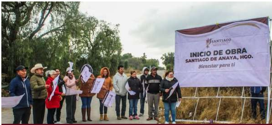
Banderazo de inicio de la obra "Construcción de guarniciones y banquetas en Manzana Centro y Manzana la Cruz", en favor del alumnado y población en general.
