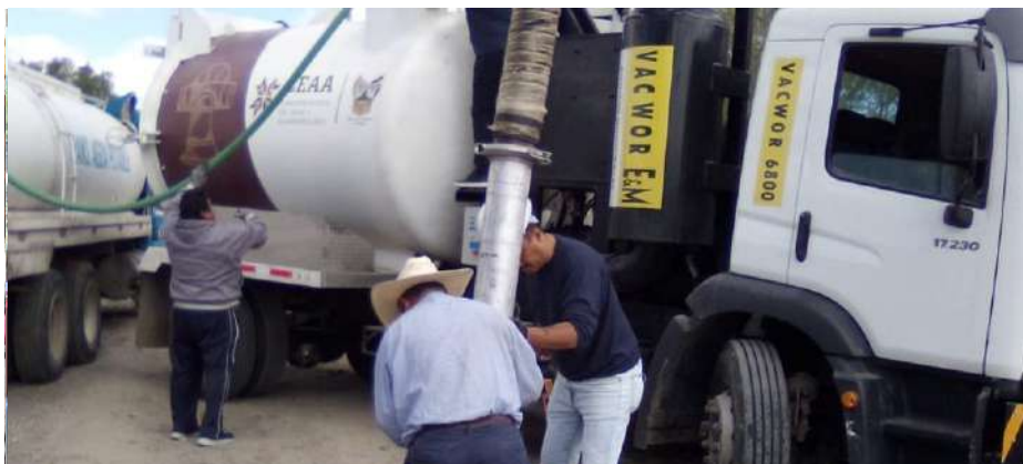
Gracias a las gestiones de la Presidenta Municipal Arq. Danay Angeles ante la Comisión Estatal del Agua y Alcantarillado, dan inicio los trabajos con el camión vector, atendiendo trabajos de saneamiento y alcantarillado
