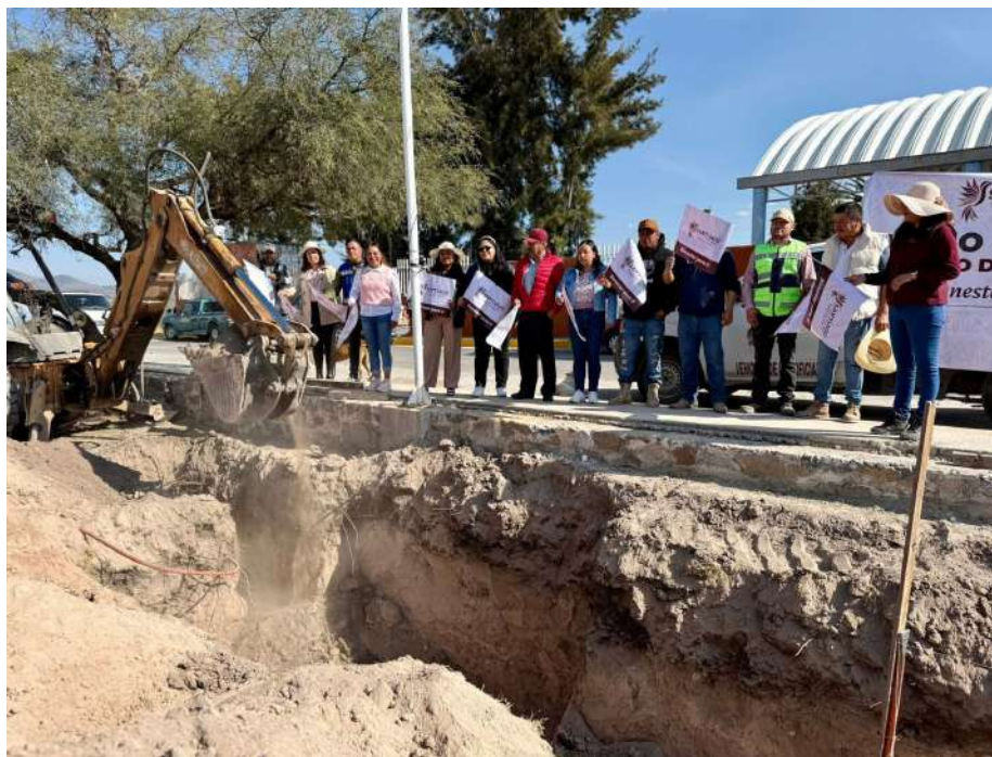
Inicio obra “Construcción de zapatas para techado de canchas” con una inversión de FAISM 2025, en la localidad de González Ortega.
