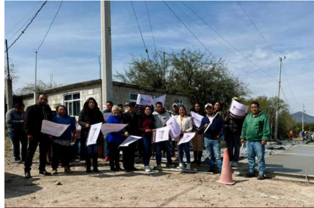
Se da inicio a la Construcción de Pavimentación Hidráulica en la calle El Dengui, en Gonzalez Ortega
