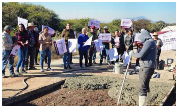
Se dio inicio a la obra: “Construcción de pavimentación hidráulica en la calle Camino a los Pérez”, en la localidad de Xitzo Mza. Sur.
