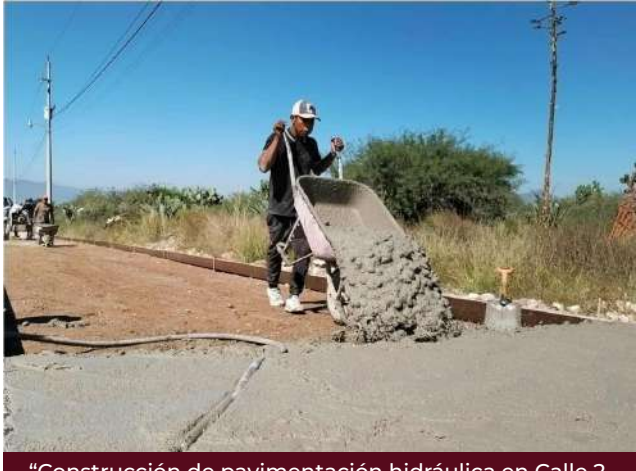
"Construcción de pavimentación hidráulica en Calle 2 de Febrero, Manzana 4, 2ª Etapa, en la Sección Sur", con una meta de 1,085 m 2 , equivalente a 157 metros de longitud por 7 metros de ancho.
